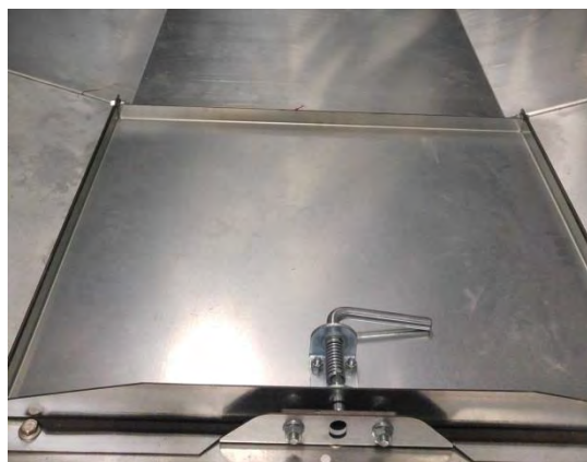
Image 37 – Plenum divider door
