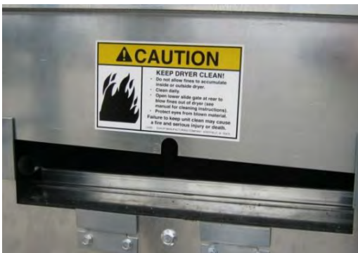
Image 27 – Plenum cleanout/blowout door
