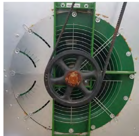
Image 3-5 – Fan intake baffles
